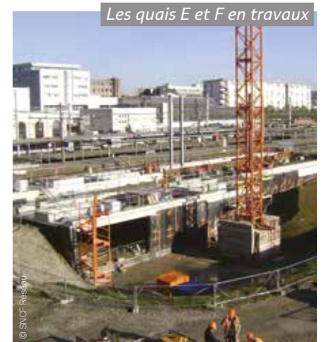
Les quais E et F en travaux
